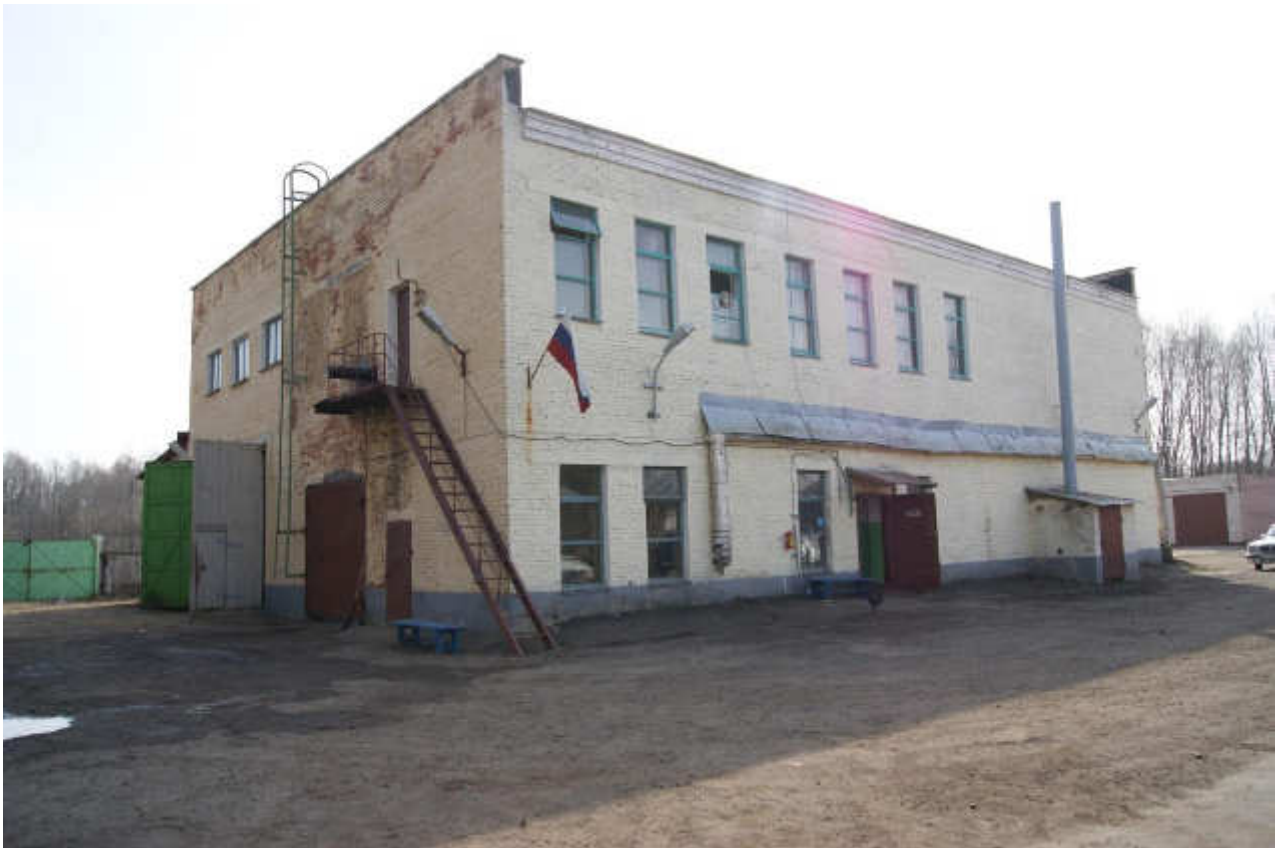
Рисунок 1.14 Фасад здания с центральным входом КНС-5
