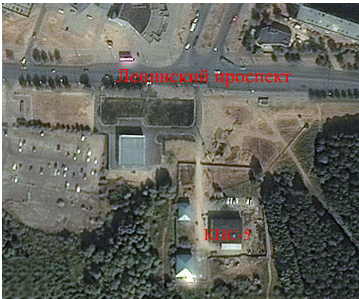
Рисунок 1.13 Вид сверху канализационной насосной станции №5
