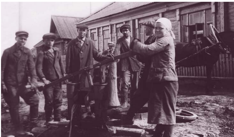
Так строился Водоканал г. Йошкар-Олы
