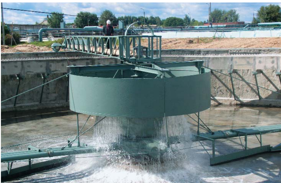
Очистные сооружения канализации
