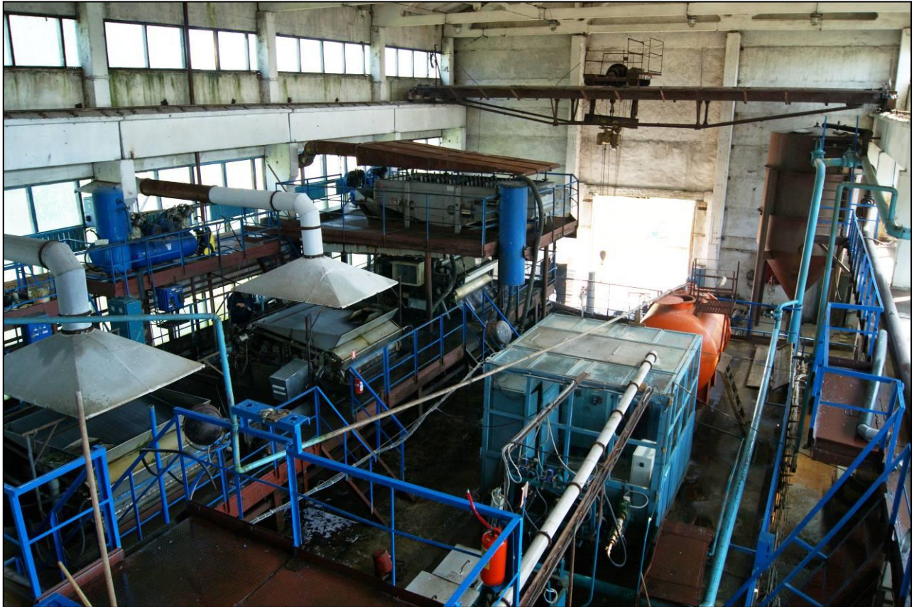
Рисунки 1.53-54 Внутренний интерьер производственного помещения цеха механического обезвоживания.
