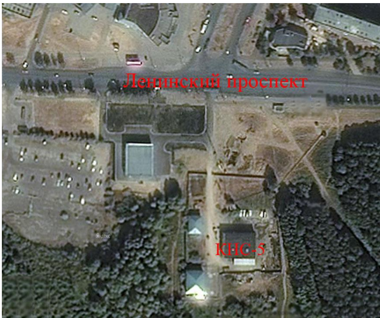
Рисунок 1.13 Вид сверху канализационной насосной станции №5
