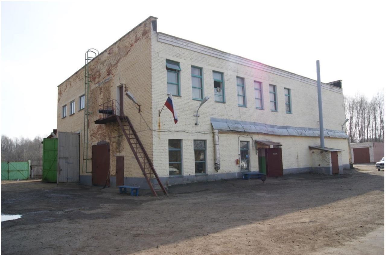
Рисунок 1.14 Фасад здания с центральным входом КНС-5
