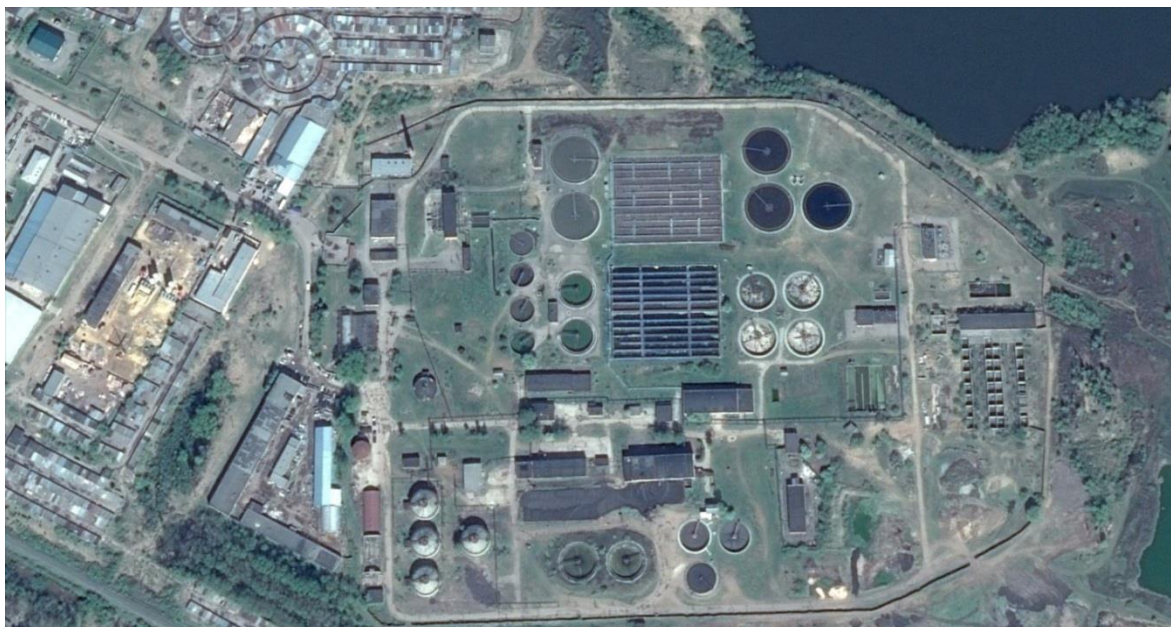
Рисунок 1.38 Канализационные очистные сооружения города Йошкар-Ола.
